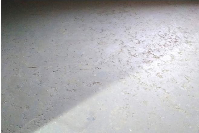
Obrázok 5 Renovácia domu. Cementová podlaha bola nahradená nabíjanou hlinenou s využitím drevených štiepok, zrecyklovaných z čias podliehajúcich renovácii.
