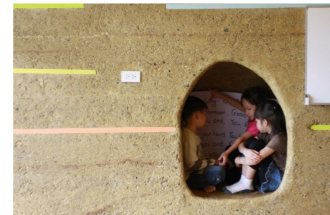
Obrázok 2 hlinená nabíjaná stena v škôlke so skrýšou pre deti Figure 2 Rammed earth wall in kindergarten with a shelter for children
