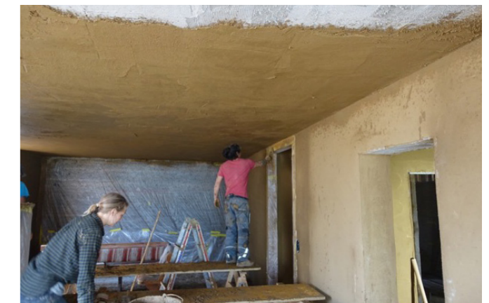
Obrázok 4 Renovácia domu. Nenosný betón bol nahradený hlinou.
