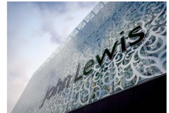
Obrázok 10. Príklad ornamentálnej fasády objektu John Lewis Department Store v Leicesteri (foto: Interpane, Objekt-design: FOA – Foreign Office Architects, Londýn) Zdroj http://www.uzemneplany.sk/clanok/siete-a-ornament-v-sucasnej-digitalnej-architekture
