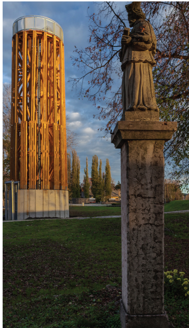
Obrázok 5 Vyhliadková veža Kravany nad Dunajom - Karva 2011 čistota konštrukcie betón, drevo, oceľ Figure 5 Observation tower Kravany nad Dunajom -Karva 2011 purity of construction concrete, wood, steel
