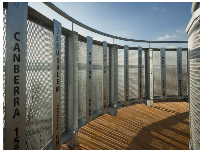
Obrázok 6 Vyhliadková veža Kravany nad Dunajom - Karva 2011 čistota konštrukcie betón, drevo, oceľ Figure 6 Observation tower Kravany nad Dunajom -Karva 2011 purity of construction concrete, wood, steel
