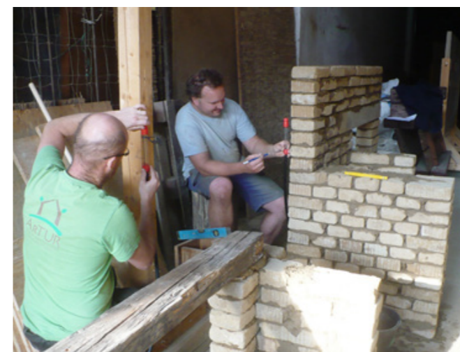
Obrázek 07 Zkouška dle Národní soustavy kvalifikací (NSK) pro získání profesní kvalifikace Zhotovitel hliněných staveb, Hostim, září 2019.
