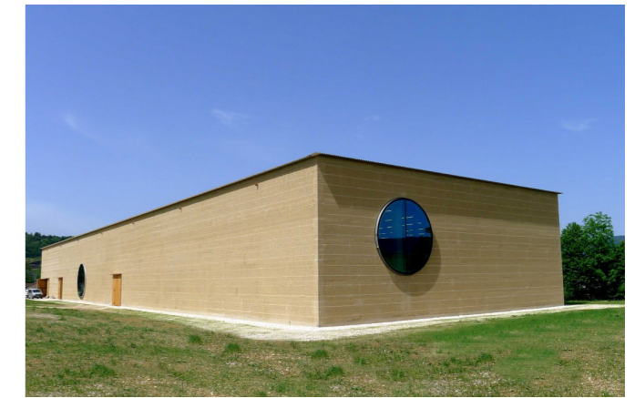
Obrázok 3 Nabíjaná hlina - sklad bylín pre výrobcu Ricola vo Švajčiarsku
